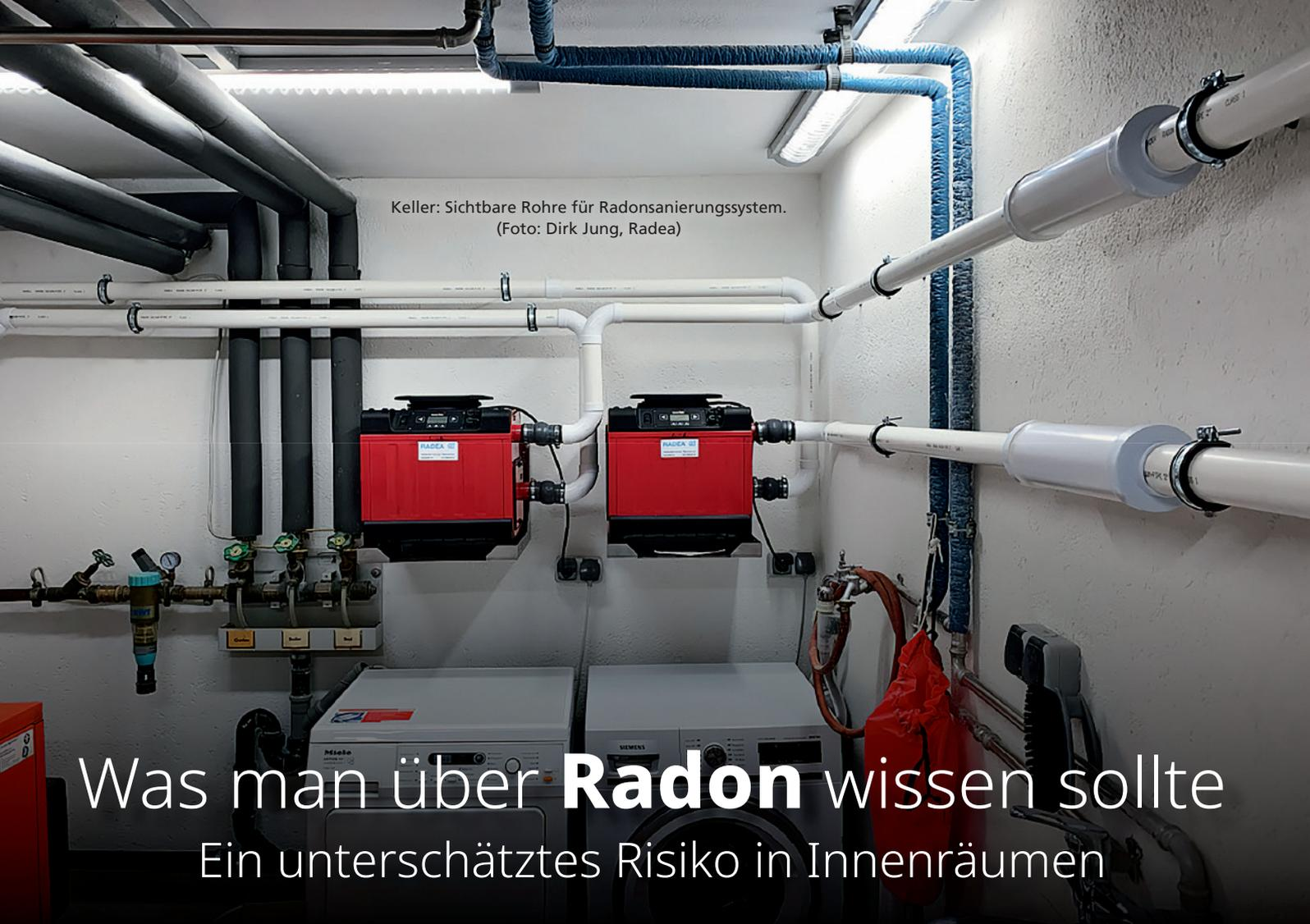
Keller: Sichtbare Rohre für Radonsanierungssystem.
